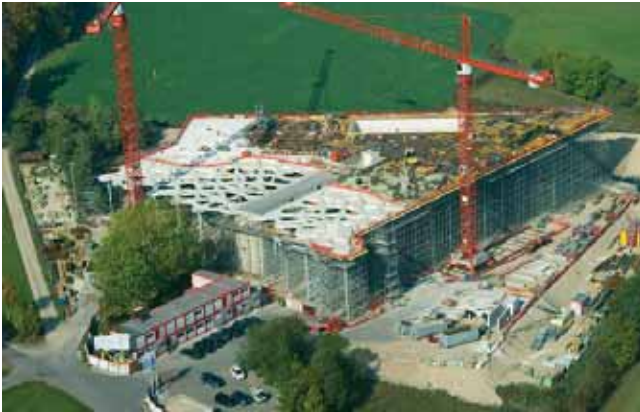
Gesamtansicht des Gebäudes in der Landschaft des Jura. Aperçu de l'ensemble du chantier.
