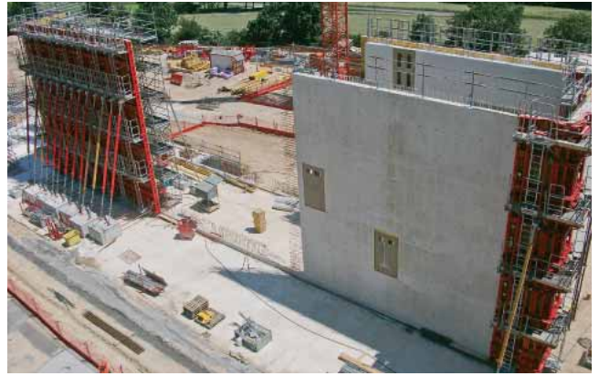
Die zwölf Meter hohen Wände der Bibliothek wurden jeweils in einem Arbeitsgang betoniert.
