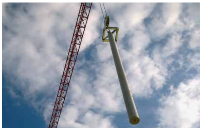
Versetzen einer der 96 vorfabrizierten Stützen mit ZEUS®-Stahlpilz. Mise en place d'un de 96 piliers avec tête anti-poinçonnement ZEUS®.
