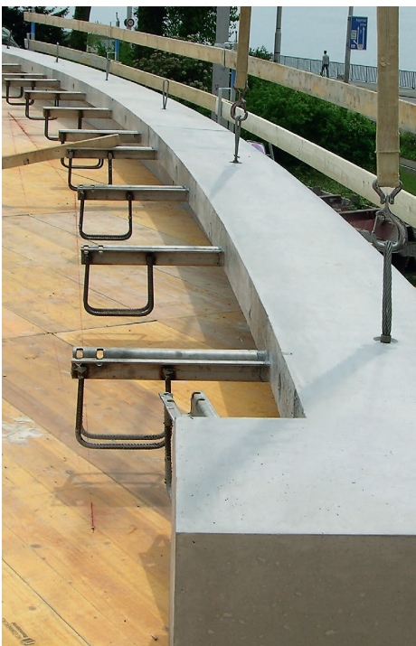
Versetzarbeiten der vorfabrizierten Dachrandelemente. Eléments préfabriqués en béton posés avant le bétonnage de la dalle.
