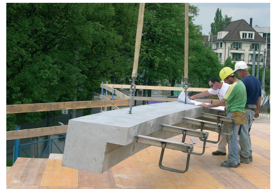
Versetzarbeiten der vorfabrizierten Dachrandelemente. Éléments préfabriqués en béton posés avant le bétonnage de la dalle.
