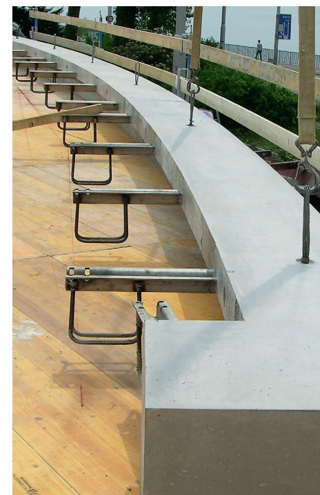
Versetzarbeiten der vorfabrizierten Dachrandelemente. Éléments préfabriqués en béton posés avant le bétonnage de la dalle.
