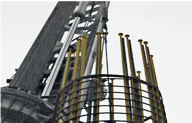
Pfeilkopfdetail in Fahrbahnplatte Encastrement de pieux d'une dalle de roulement
