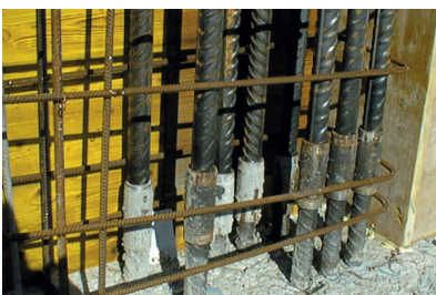
BARON®-Schraubbewehrungen BARON® coupleurs d'armatures
