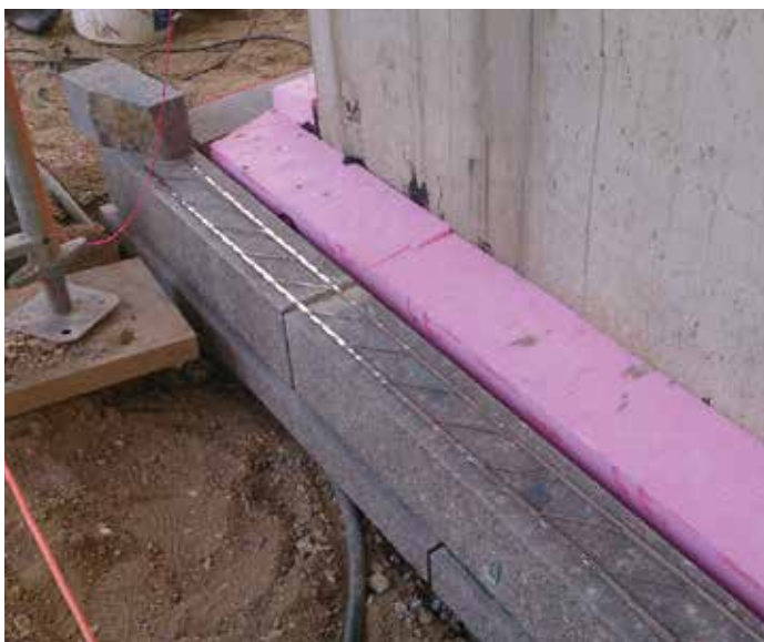
mit MURINOX®-Lagerfugenbewehrung verstärktes Mauerwerk
