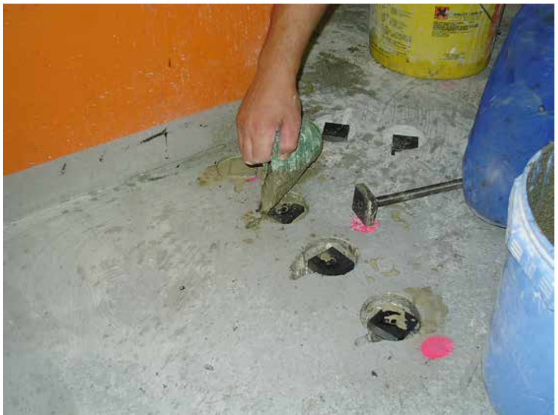
Vergießen der ancoSAN® mit speziellem Fließmörtel Grouting the ancoSAN® with special flowable mortar
