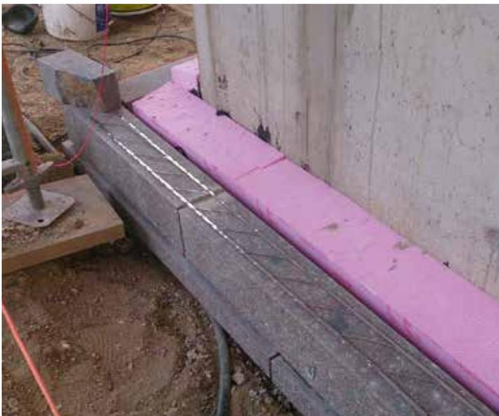
mit MURINOX®-Lagerfugenbewehrung verstärktes Mauerwerk
