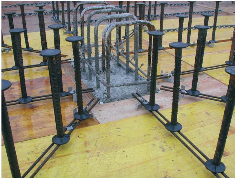
ancoPLUS® in Deckenunterzug (vorgängige Montage) ancoPLUS® in beam (preceding Assembly)
