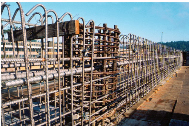
Brückenquerträger mit Edelstahlbewehrung
