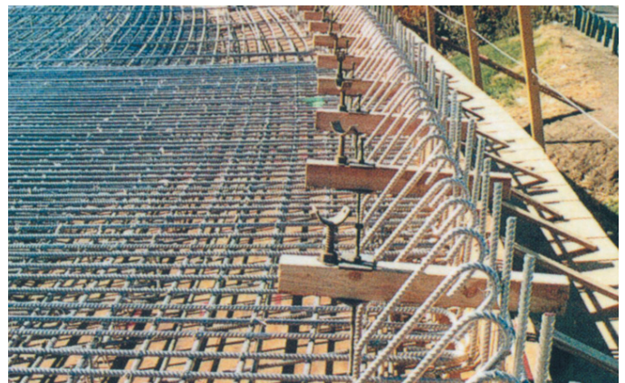
New Jersey-Randträger mit Edelstahlbewehrung
