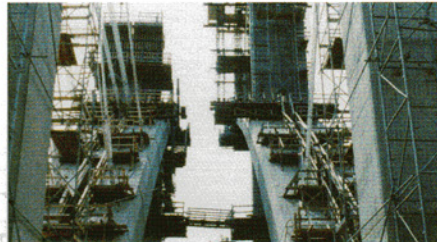
Schrammbord-Schalung Kerb shuttering for deck edges Coffrage de bordures d'accotements carrossables
