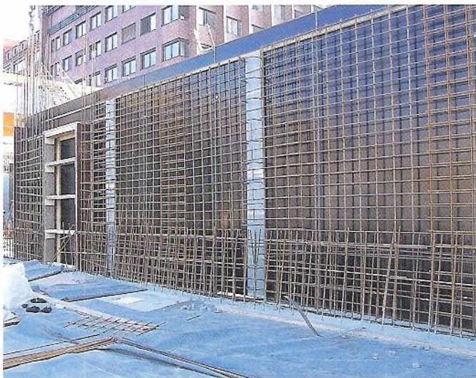
Bild 10. COMAX P Rückbiegeanschlüsse, Einbauzustand Betonierabschnitt 1
