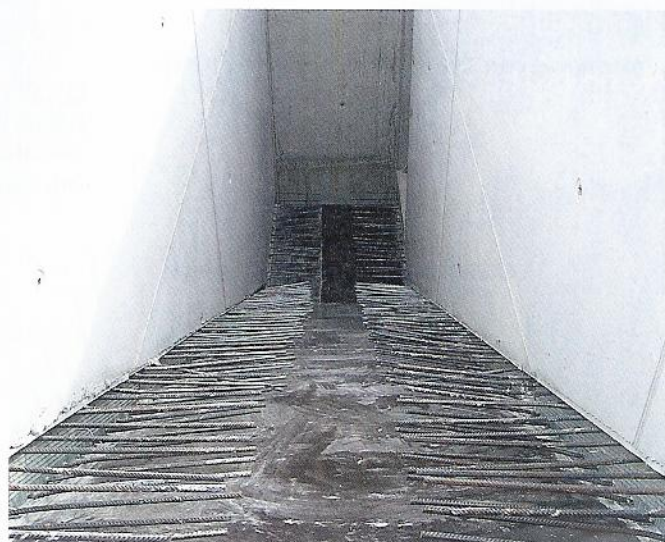
Bild 24. COMAX P Rückbiegeanschluss für eine Treppe, ausgebogene Bewehrungsstäbe
