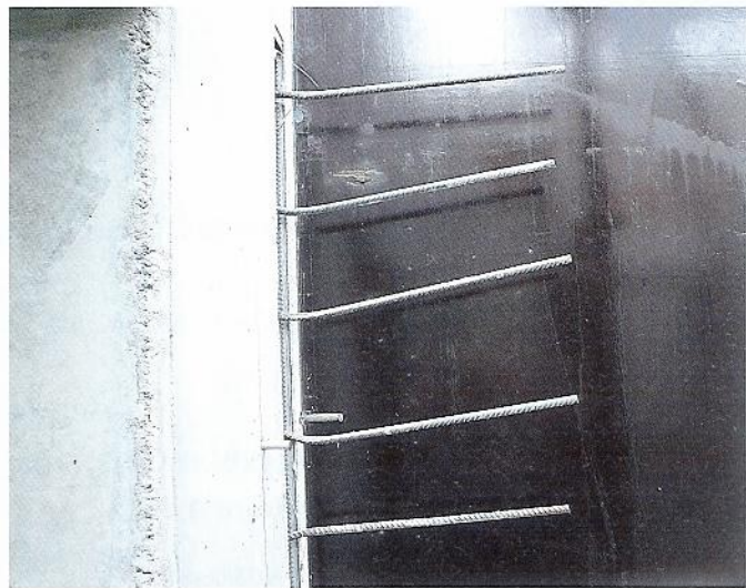
Bild 12. COMAX P Rückbiegeanschluss, zurückgebogene Bewehrungsstäbe im Betonierabschnitt 2
