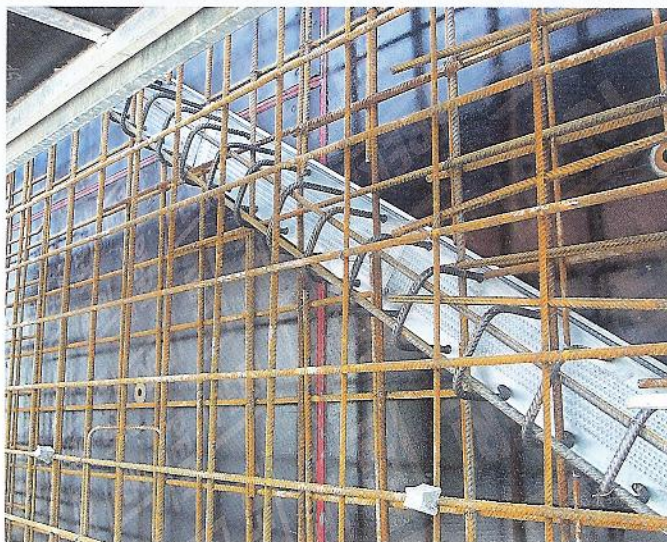
Bild 23. COMAX P Rückbiegeanschluss für eine Treppe, Einbauzustand Betonierabschnitt 1
