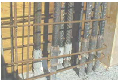
BARON® csavarozható vasalatok BARON® screw-in reinforcement
