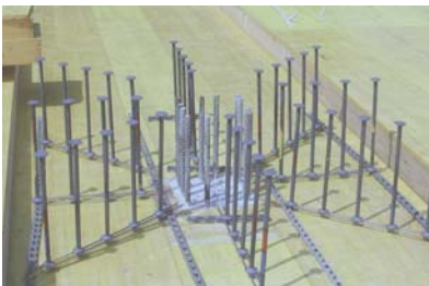
ancoPLUS® átszűrődési vasalatok ancoPLUS® punching shear reinforcement
