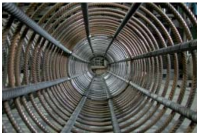
Acél feldolgozás S500 S500 steel processing
